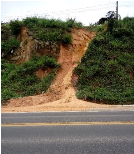
Figura 6. Deslizamento na Br-423, porção NNO de Garanhuns.
